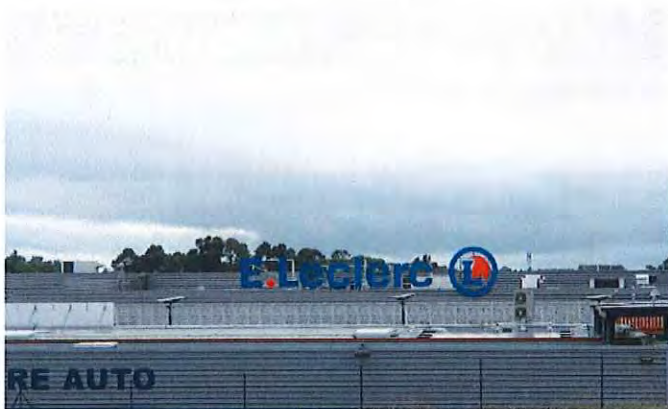
Enseigne sur toiture (exemple pris en dehors du territoire de Val d'Isère)
