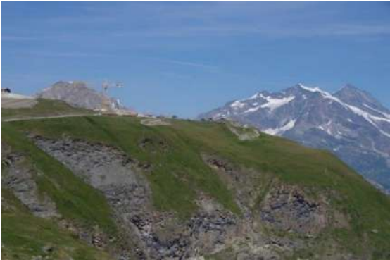
La Tête de Solaise, avec l'accès par les pistes en travaux
