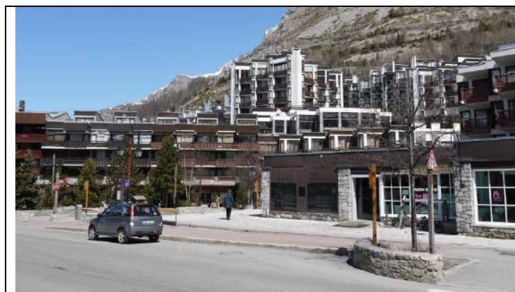
Centre de Val d'Isère
