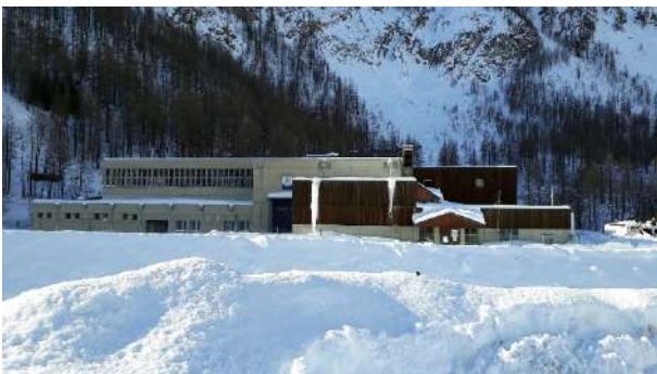
Centrale de Val d'Isère
