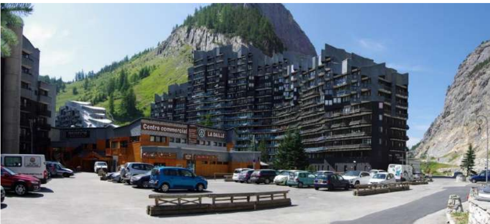
Déjà présent sur les cartes d'Etat-major, le hameau de la Daille est clairement identifiable par son architecture de bâti collectif datant de la fin des années 1960
